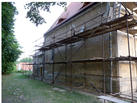
06-oprava venkovní fasády severní strany lodi a sakristie / Der Außenputz der nördlichen Seite des Kirchenschiffs und der Sakristei wird saniert
