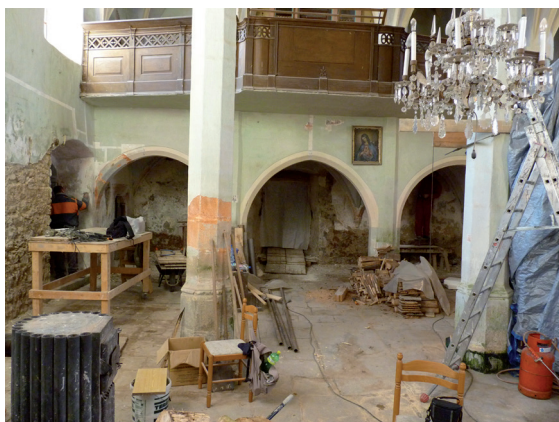
03-pohled ke kůru během opravy lodi kostela / Ansicht der Empo- re während der Sanierung
