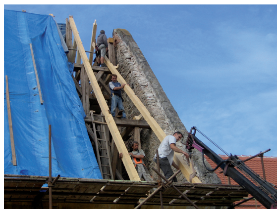
09-usazování nových trámů - krok- ví na krov lodi / Einbringen neuer Balken und Dachsparren
