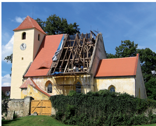
05-nová fasáda i střecha věže / Austausch des Dachstuhl im süd- lichen Teil des Kirchenschiffs
