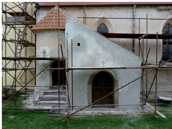
05-oprava venkovní fasády jižní strany kostela / Der Außenputz der südlichen Seite der Kirche wird saniert
