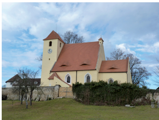
12-jihní pohled na opravený kostel / Sanierte Kirche, Ansicht von Süden
