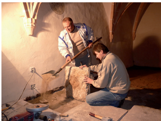
10-kameník pan Lavička spolu s kolegou při práci na doplnění nové dlažby pod kruchtou / Steinmetz Lavička mit seinem Kollegen bei der Arbeit – unter der Empore werden neue Fliesen gelegt
