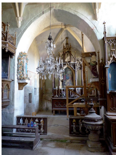
01-presbytář během restaurátorských prací / Presbyterium vor Beginn der Sanierungsarbeiten
