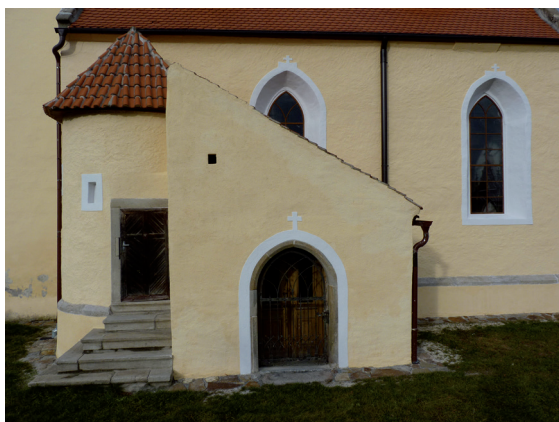
10-detail jižní části venkovní fasády kostela po opravě a nátěru / Ausschnitt des südlichen Teils der Kirchenfassade nach Sanierung und Anstrich
