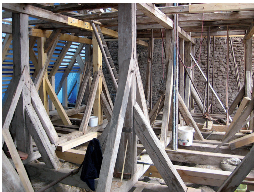
06-výměna krovu na jižní části lodi / Dachstuhl des Kirchenschiffs von In- nen in Richtung Presbyterium gesehen
