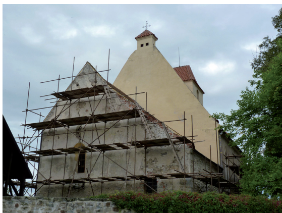
04-oprava venkovní fasády východní strany sakristie a presbytáře / Der Außenputz der Ostseite von Sakristei und Presbyterium wird saniert
