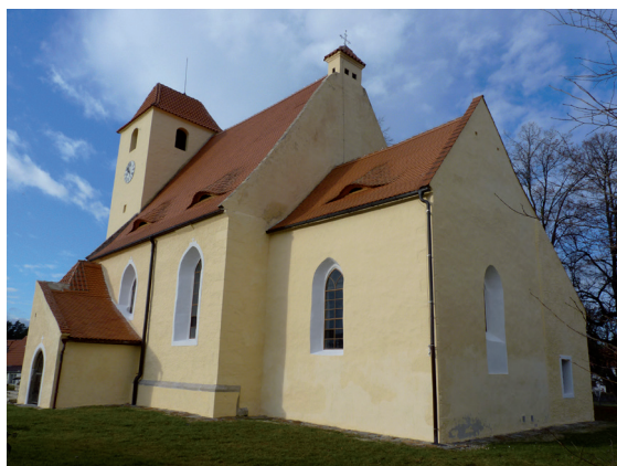
11-opravená jižní část venkovní fasády kostela / Die sanierte südliche Kirchenfassade
