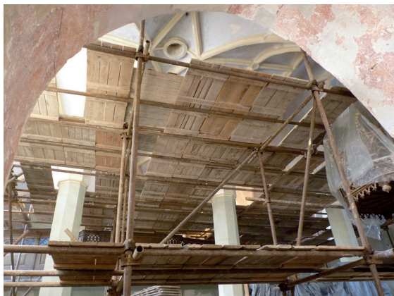
04-lešení uvnitř interiéru / Gerüst im Innenraum
