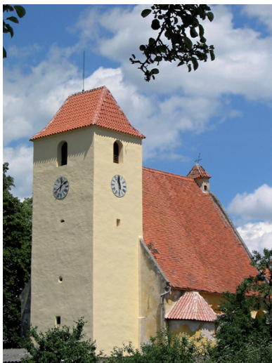
04-nová fasáda i střecha věže / Kirchturm mit neuem Außenputz und neuem Dach
