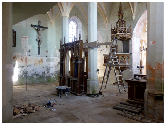
01-interiér lodi kostela před opravou / Kirchenschiff vor der Sanierung
