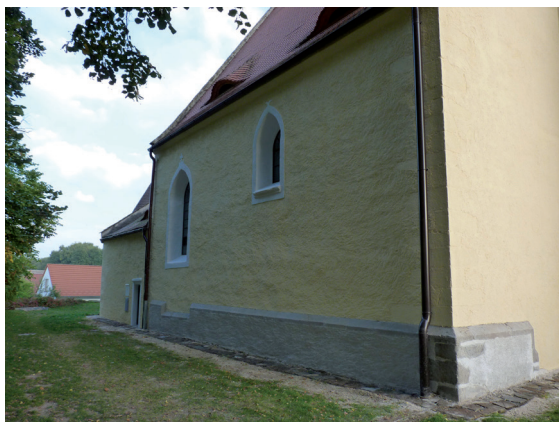
09-severní část venkovní fasády po opravě a nátěru / Der nördliche Teil des Außenputzes nach Sanie- rung und Anstrich
