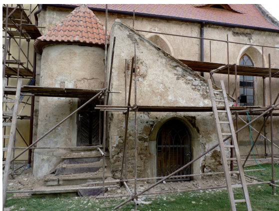
03-otlučená venkovní omítka na jižní straně lodi kostela / Der Außenputz der südlichen Seite des Kirchenschiffs wird abgeschlagen
