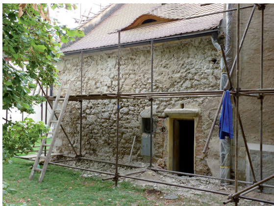
02-otlučená venkovní omítka sakristie / Der Außenputz der Sakristei wird abgeschlagen
