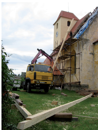
08-montáž nových trámů na jižní stranu krovu lodi / Montage neuer Tragebalken im südlichen Teil des Dachstuhl
