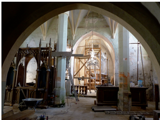
02-pohled zpod kůru do lodi a presbytáře kostela před opravou / Das Kirchenschiff und das Presbyterium vor der Sanierung, Ansicht vom Eingang (unter der Empyre) Richtung Altar
