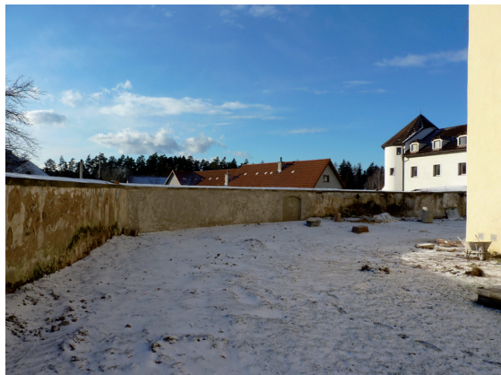
12-západní ohradní zeď po opravě / Westliche Kirchhofs- mauer nach der Sanierung
