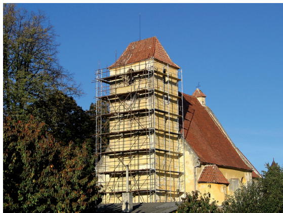
02-lešení okolo věže před začátkem opravy / Turmgerüst vor Beginn der Sanierung
